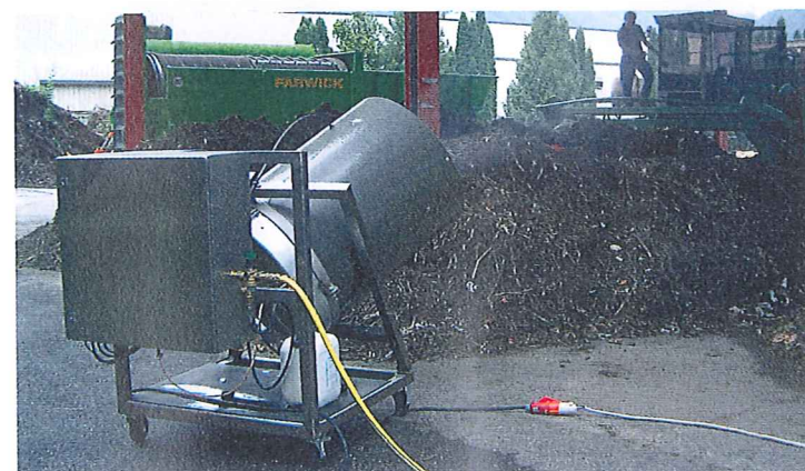
Mit der großen Vernebelungsanlage wird die gesamte Kompostanlage alle 5 Minuten mit der EMa-Lösung eingenebelt. Damit hat man die Geruchsproblematik grundsätzlich gelöst.
