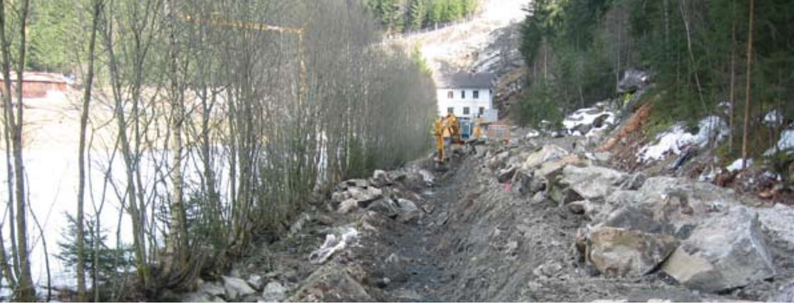
Wasserrückgabe in Bau
