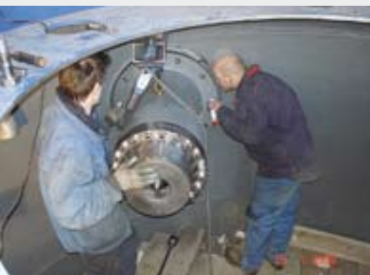
Montage der Einspritzdüsen
