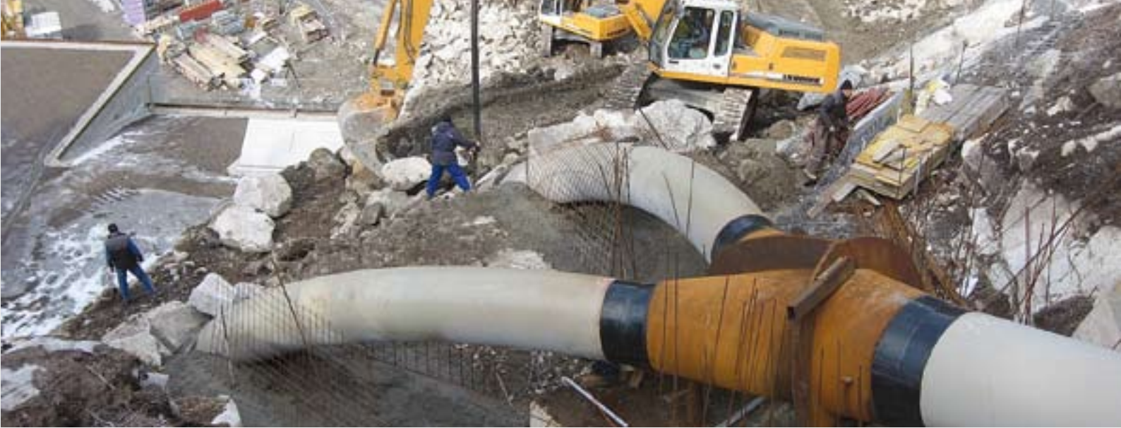
Bauarbeiten: Hosenrohr, Wasserteilung für die 2 Turbinen
